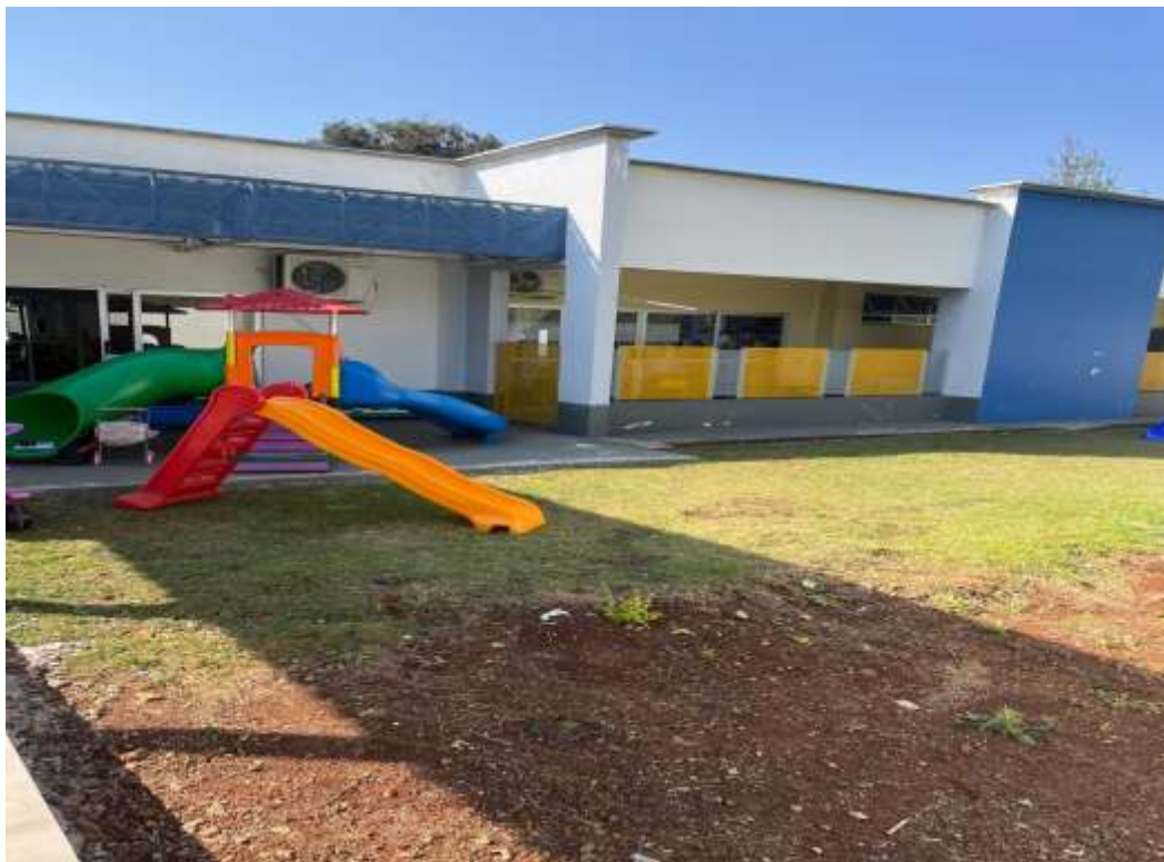
Foto 02: Local para construção do pátio coberto;
