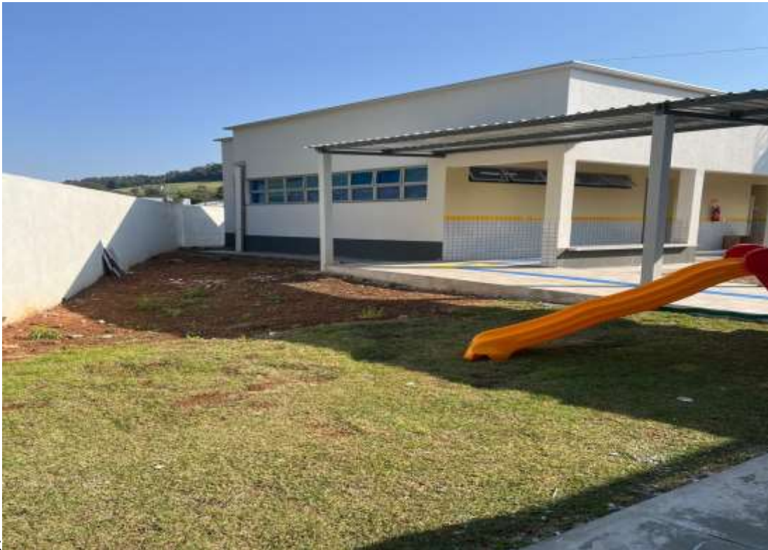
Foto 01: Local para construção do almoxarifado;
