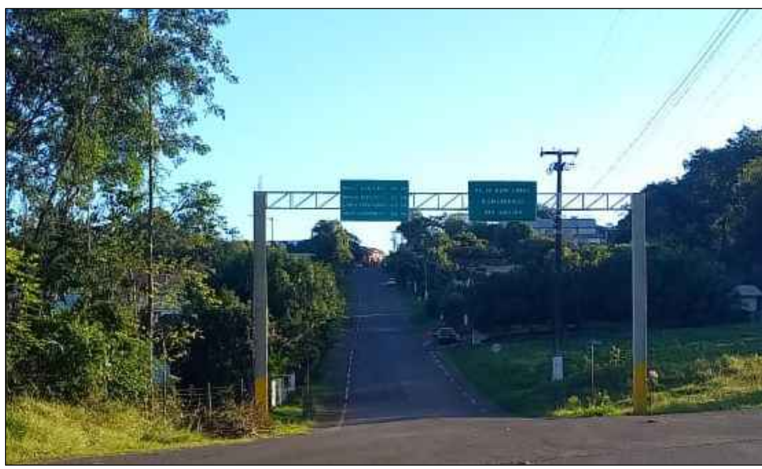
FOTO TRECHO 01: RUA PRINCIPAL RIO GAVIÃO Fonte: Município de Nova Esperança do Sudoeste
