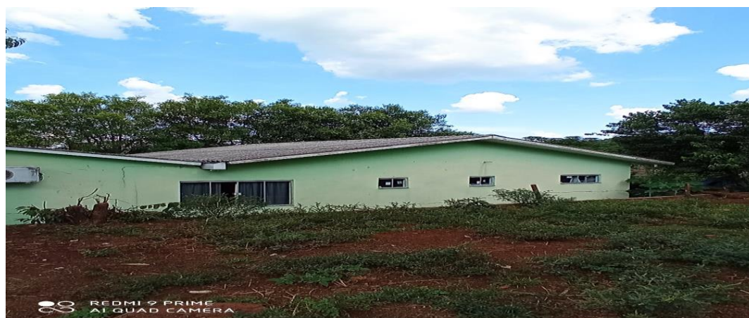
Figura 04 – Pintura externa (instalação de calhas, condutores verticais);
