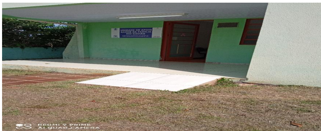
Figura 03 – Fachada (revitalização da fachada com floreira, pinturas, calçadas, rampa de acessibilidade, platibanda);
