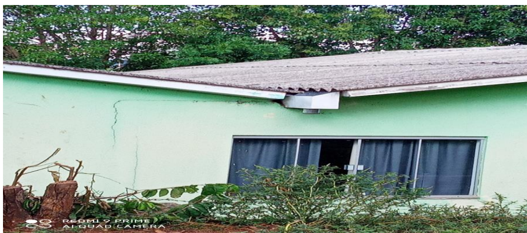
Figura 05 – Pintura externa (fechamento das trincas, instalação de calhas, pintura);
