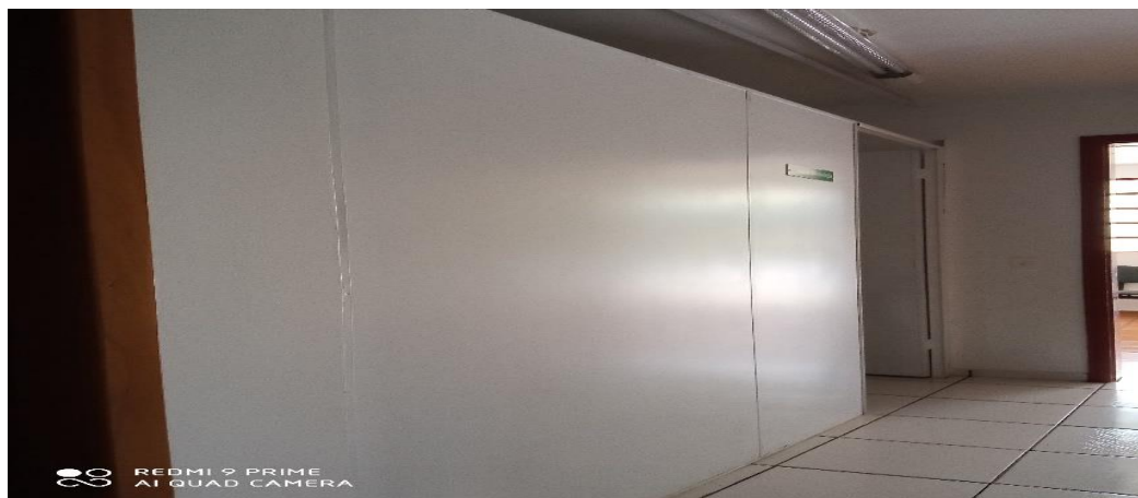
Figura 07 – Fechamento de sala com alvenaria e instalação de nova porta para sala de Odontologia;
