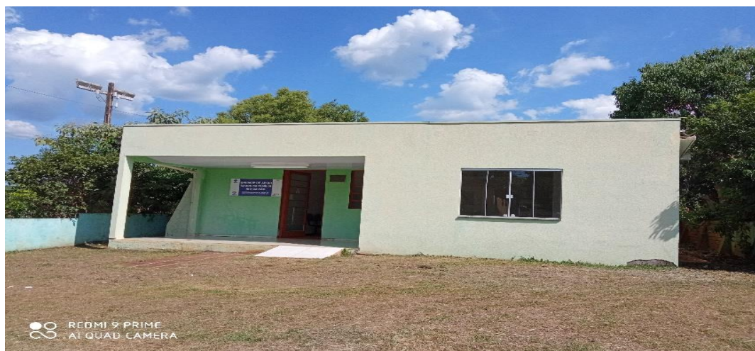
Figura 01 – Entrada Principal (instalação de porta de correr);
