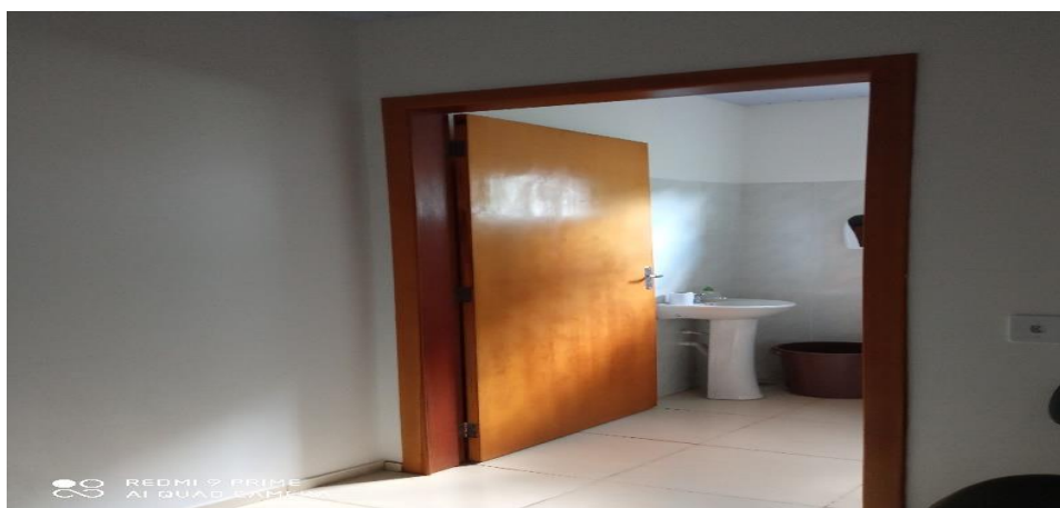
Figura 15 – Pintura interna e substituição de porta interna;
