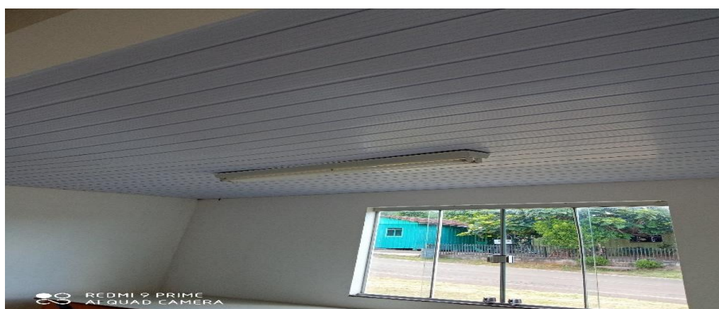
Figura 09 – Pintura interna, substituição de luminária, e troca de cantoneira de PVC;
