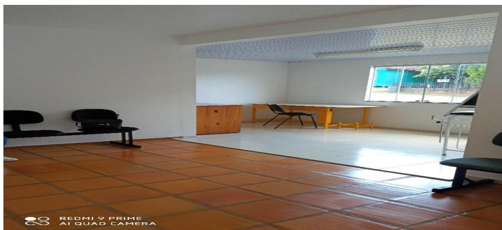
Figura 08 – Pintura interna, substituição de piso cerâmico;
