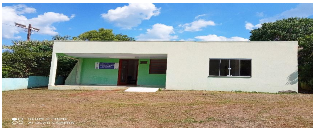
Figura 02 – Fachada (Pintura, platibanda em estrutura metálica, execução de calçadas e rampa);
