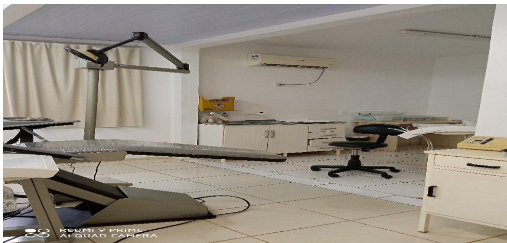
Figura 11 – Substituição de luminária, substituição de piso cerâmico;
