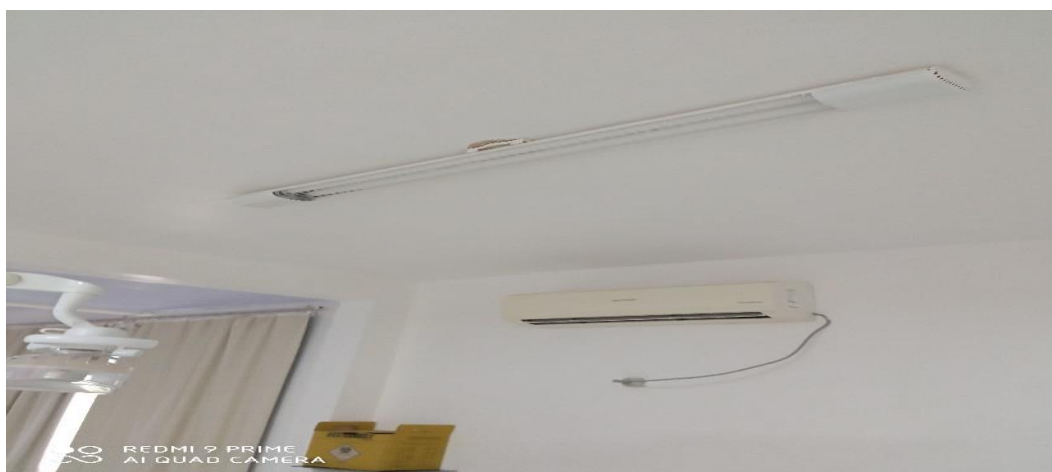
Figura 06 – Reforma nas instalações hidráulicas, pintura);
