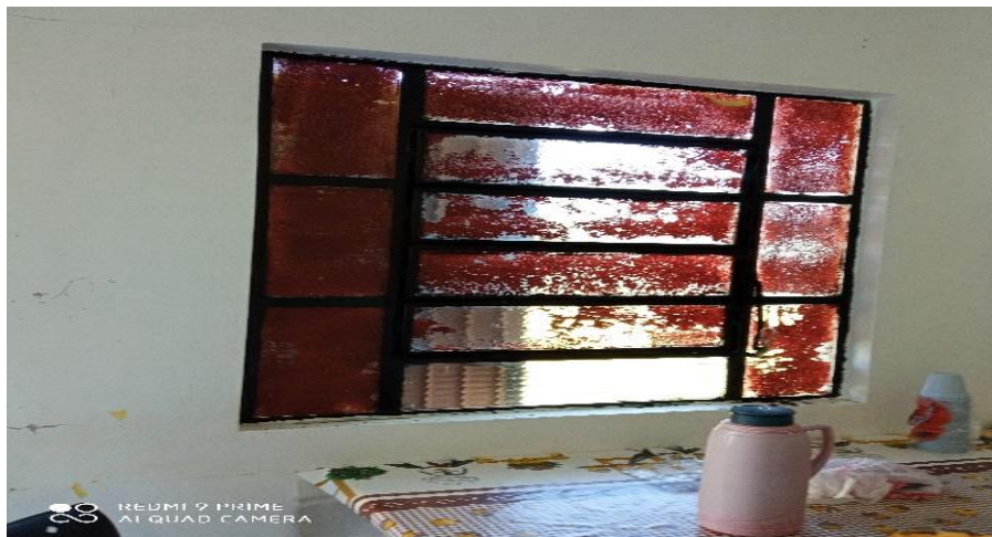
Figura 11 – Pintura dos vidros na janela da cozinha;
