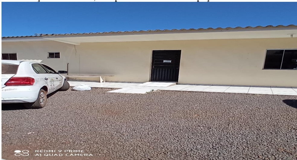
Figura 01 – Entrada Principal (instalação de porta de correr);
