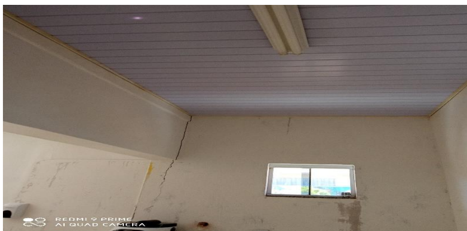
Figura 18 – Pintura interna e recuperação de trincas ;
