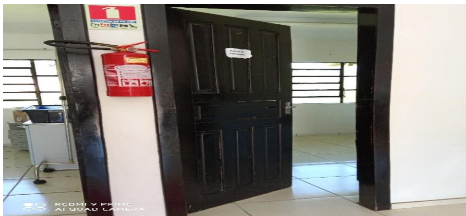
Figura 08 – Substituição de portas internas;
