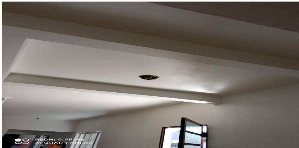
Figura 17 – Pintura da laje e instalação de luminárias;
