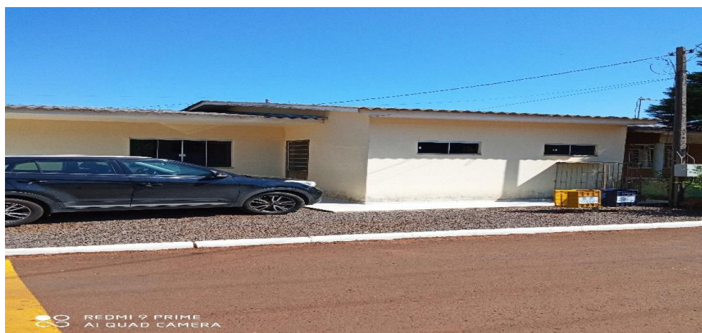
Figura 03 – Fachada (revitalização da fachada com floreira, pinturas, calçadas, rampa de acessibilidade, platibanda);
