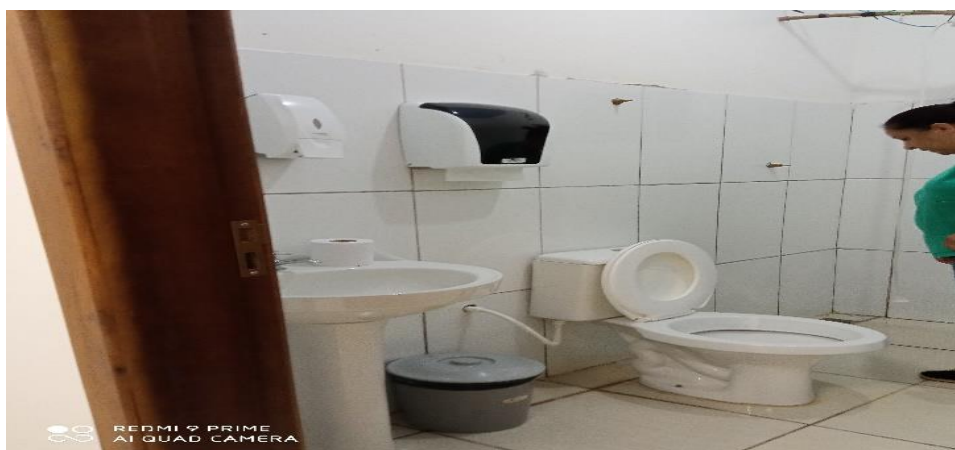
Figura 19 – Reforma de banheiros;
