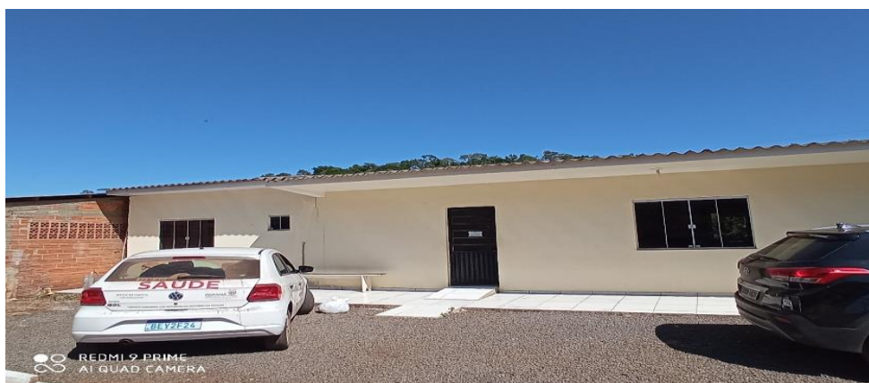
Figura 02 – Fachada (Pintura, instalação de calhas e platibanda em estrutura metálica, execução de calçadas e rampa);
