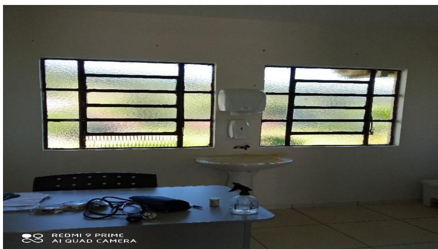
Figura 12 – Pintura interna e reforma na instalação hidro sanitária e substituição de lavatório;
