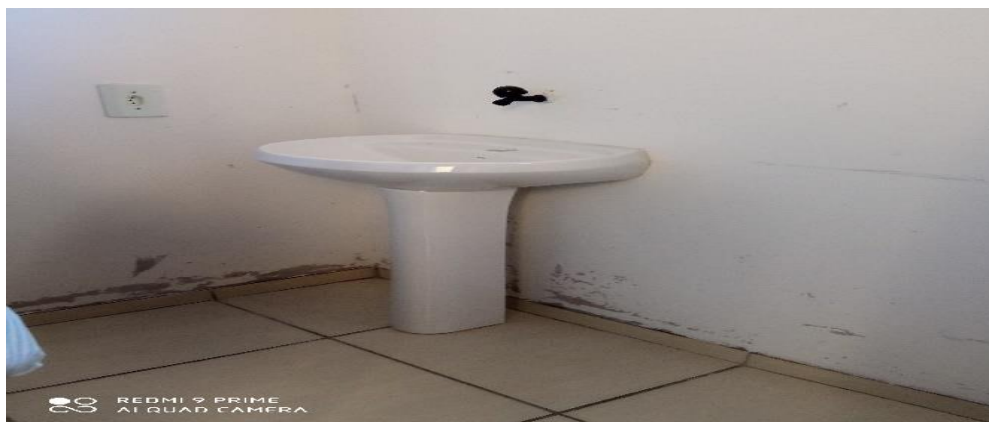
Figura 21 – Instalação de Banheiro;
