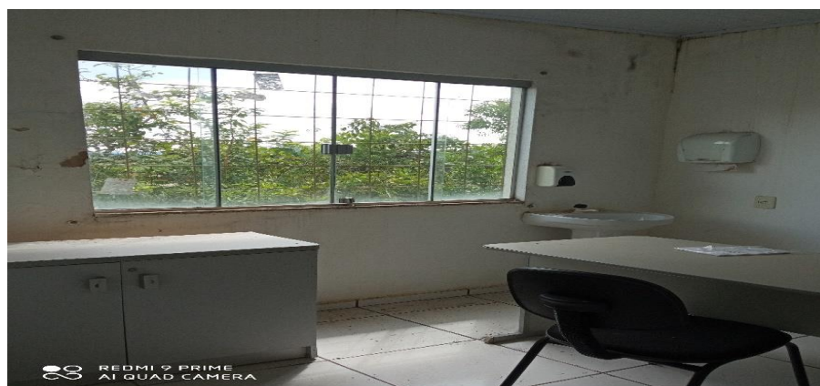
Figura 13 – Pintura interna, correção das trincas da alvenaria;
