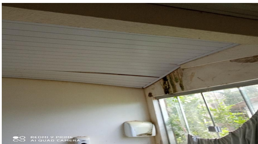
Figura 12 – Pintura interna, substituição de forro, instalação de calhas;
