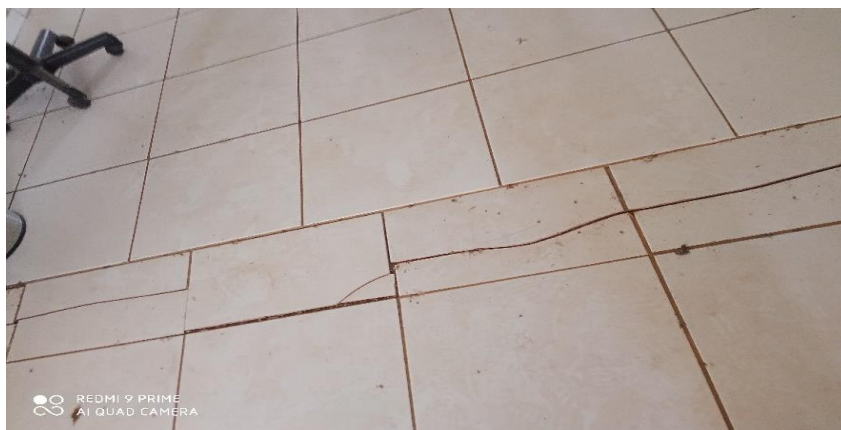
Figura 11 – Substituição do piso cerâmico;
