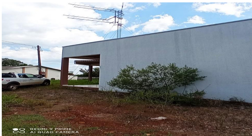
Figura 02 – Fachada (Pintura, platibanda em estrutura metálica, execução de calçadas e rampa);
