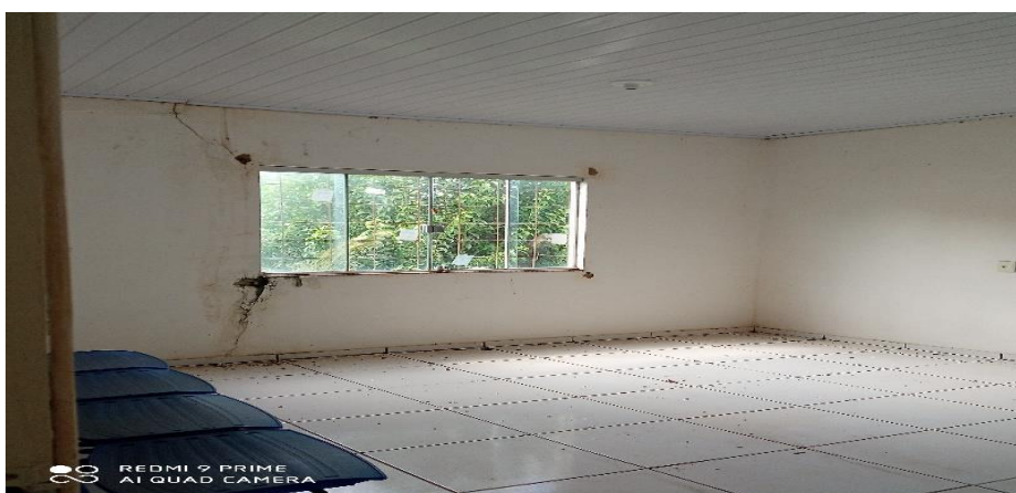
Figura 08 – Pintura interna, correção das trincas da alvenaria;
