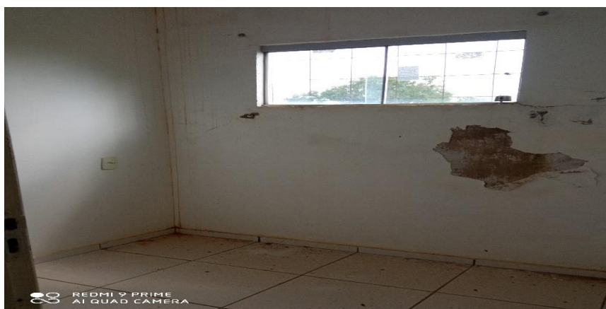
Figura 09 – Pintura interna;
