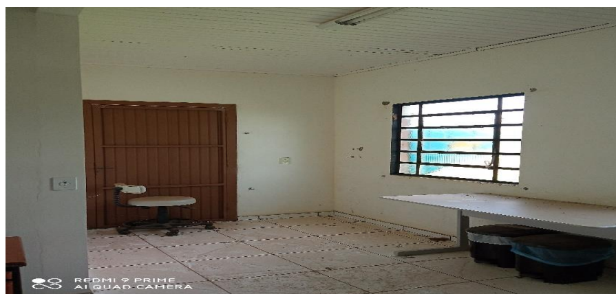
Figura 14 – Pintura interna, substituição de forro;
