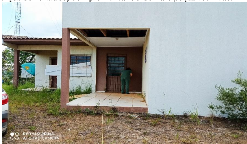
Figura 01 – Entrada Principal (Pintura, troca forro, substituição porta);
