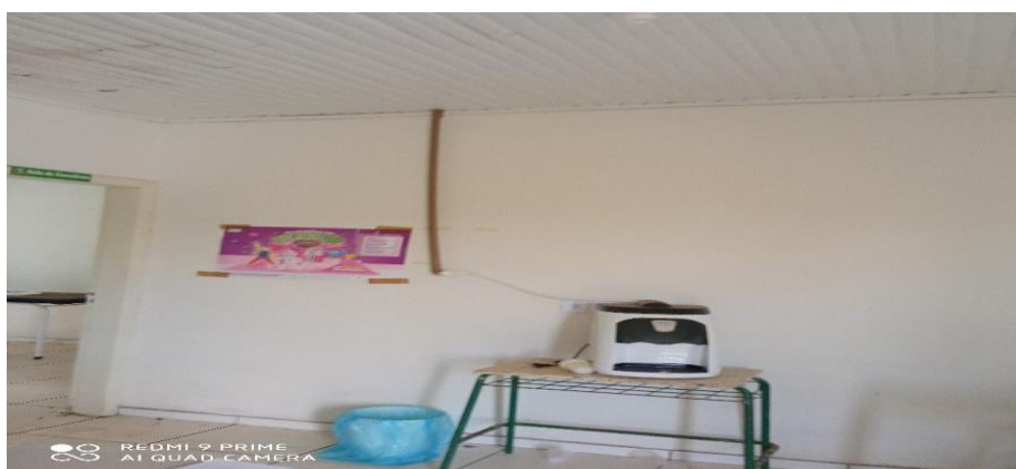
Figura 15 – Pintura interna e substituição de cantoneiras de PVS e forro de PVC danificado substituição das instalações elétricas;
