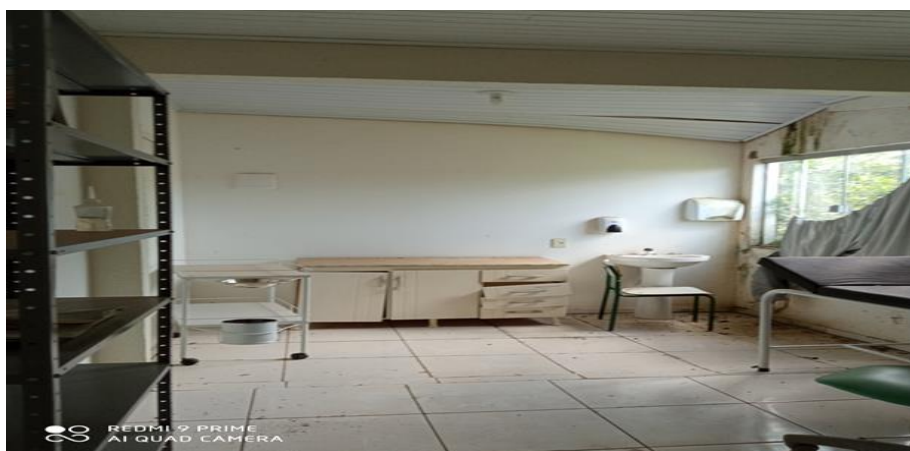
Figura 07 - Pintura interna, substituição de forro, substituição das instalações elétricas, substituição do piso cerâmico;
