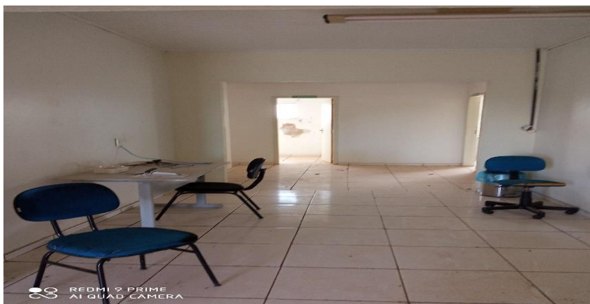
Figura 10 – Pintura interna, substituição de forro, substituição das instalações elétricas, substituição do piso cerâmico;
