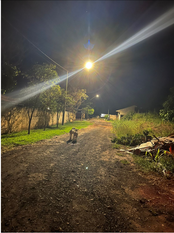
F35 – Luminárias de LED instaladas na Rua Marcílio Marchiori (noite)
