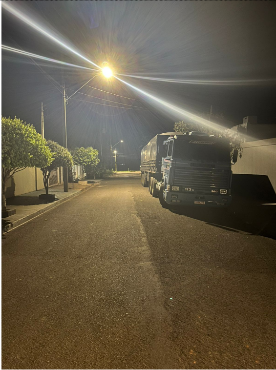
F11 – Luminárias de LED instaladas na Rua José Dias Neto (noite)
