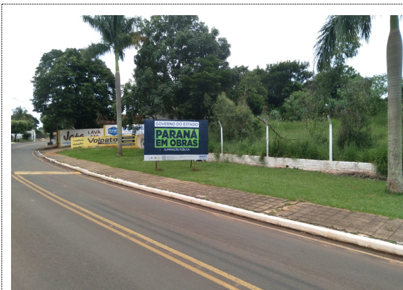
F01 – Placa de Obra instalada
