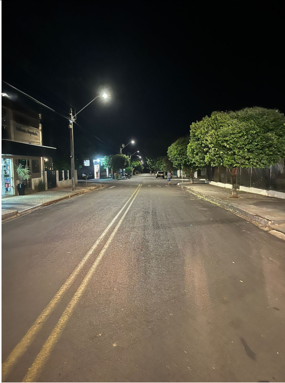
F43 – Luminárias de LED instaladas na Rua Colorado (noite)
