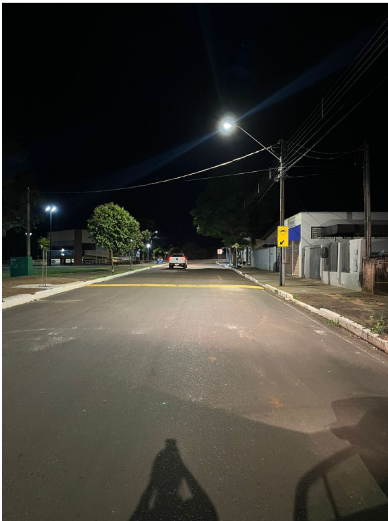
F41 – Luminárias de LED instaladas na Praça Silvério Ângelo Dallago (noite)
