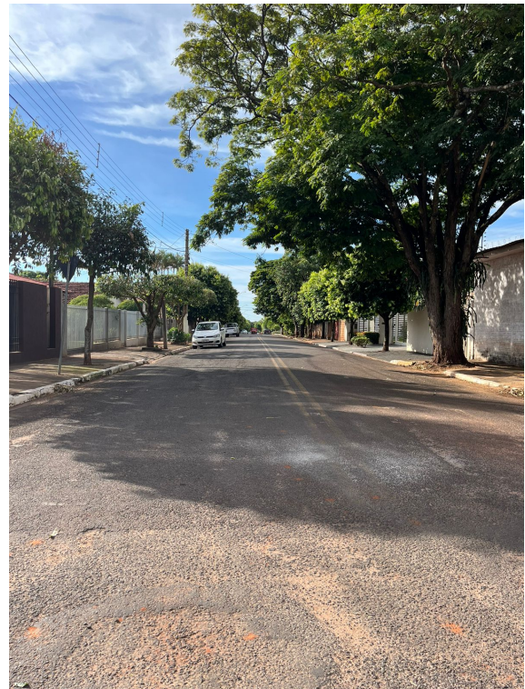
F34 – Luminárias de LED instaladas na Rua São Pedro (dia)
