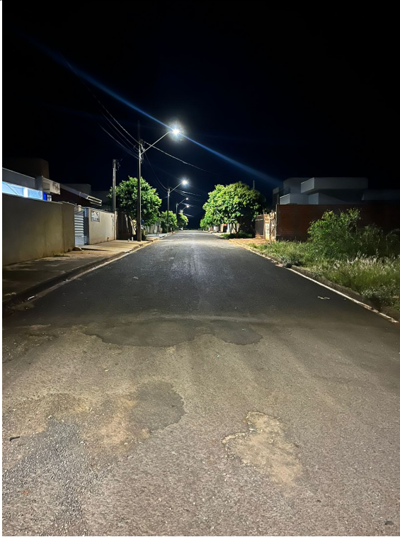
F07 – Luminárias de LED instaladas na Rua Francisco Nunes Ferreira (noite)
