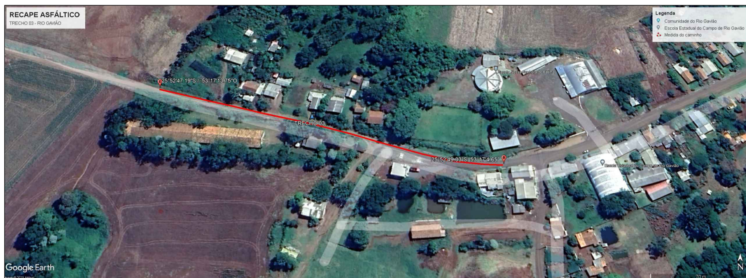
LOCALIZAÇÃO TRECHO 02 RUA PRINCIPAL FONTE: Google Earth
