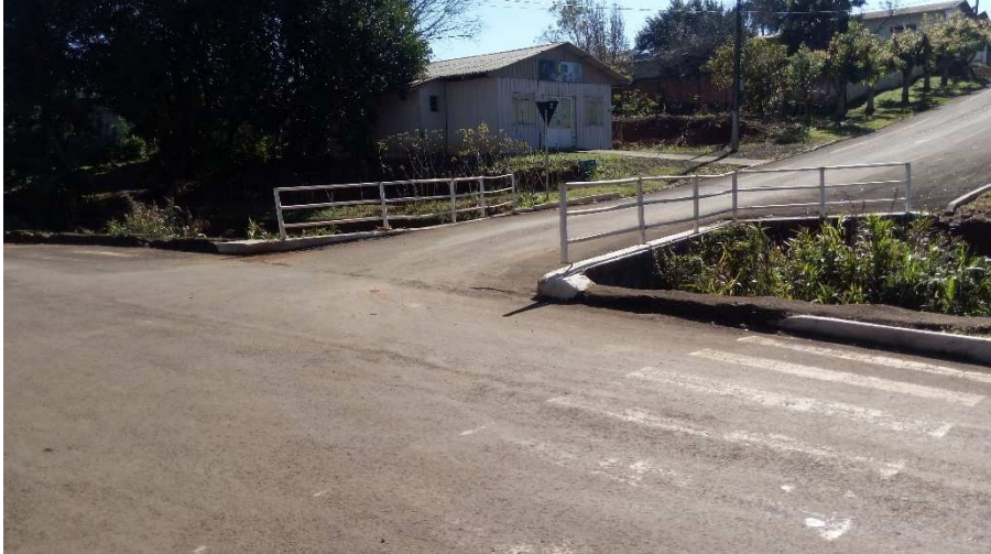
Fonte: Leonardi Engenharia (2020)
