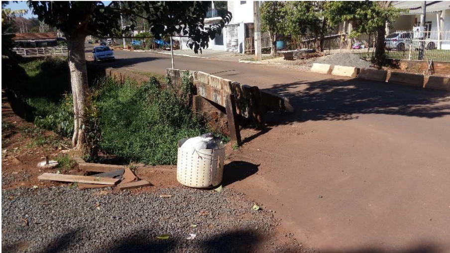
Imagem 09: Ponte na Avenida Alexandre Bonetti (Córrego São Pedro)
