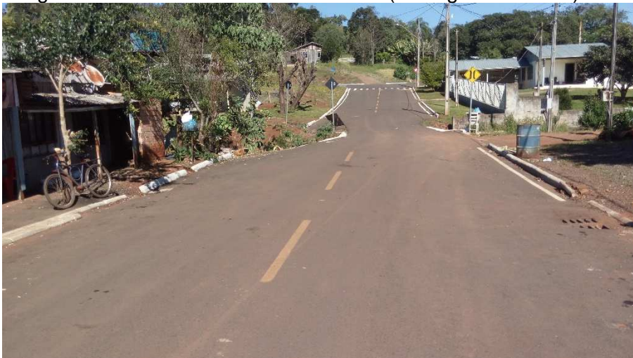
Fonte: Leonardi Engenharia (2020)
