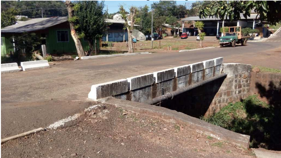
Imagem 12: Ponte na Rua Geni Fraga (Córrego São Pedro)
