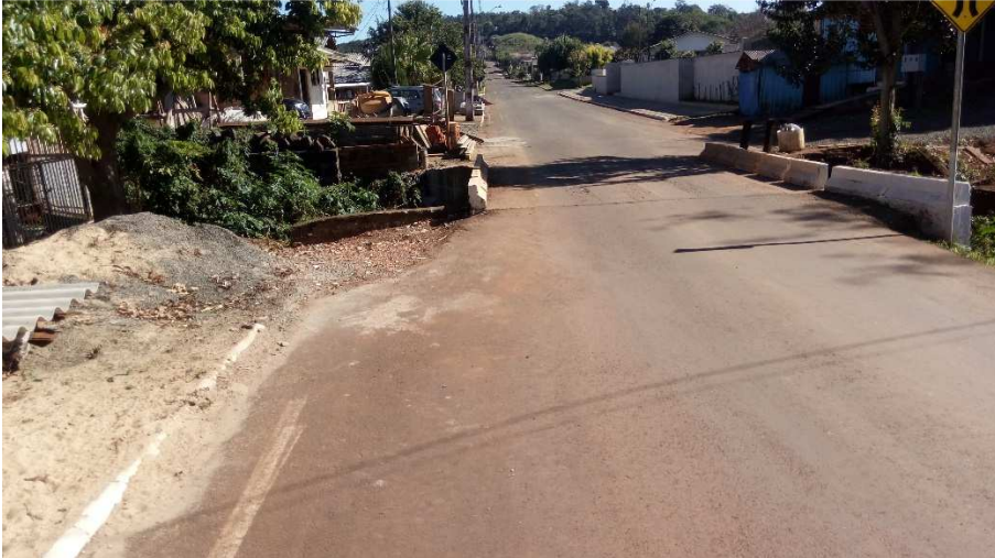
Fonte: Leonardi Engenharia (2020)
