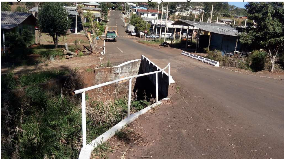
Imagem 11: Ponte na Rua Geni Fraga (Córrego São Pedro)
