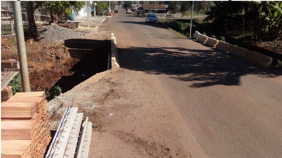
Fonte: Leonardi Engenharia (2020)
