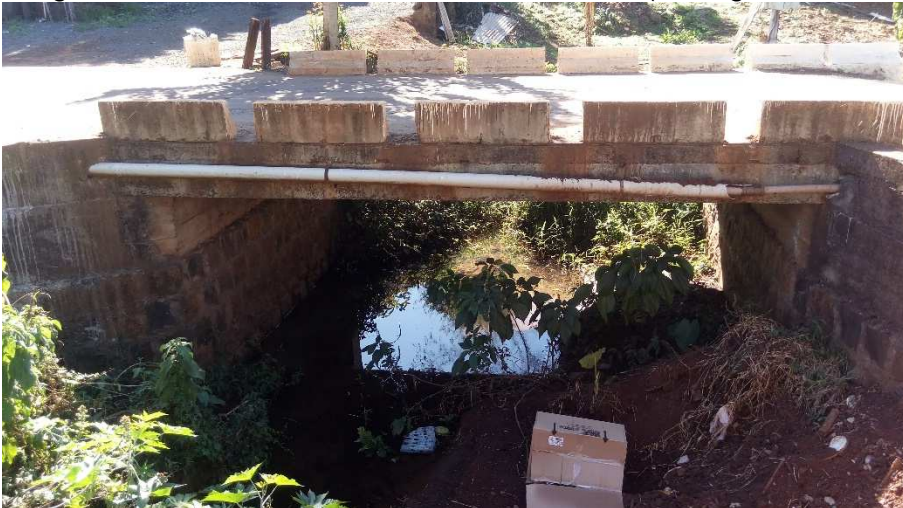
Fonte: Leonardi Engenharia (2020)
