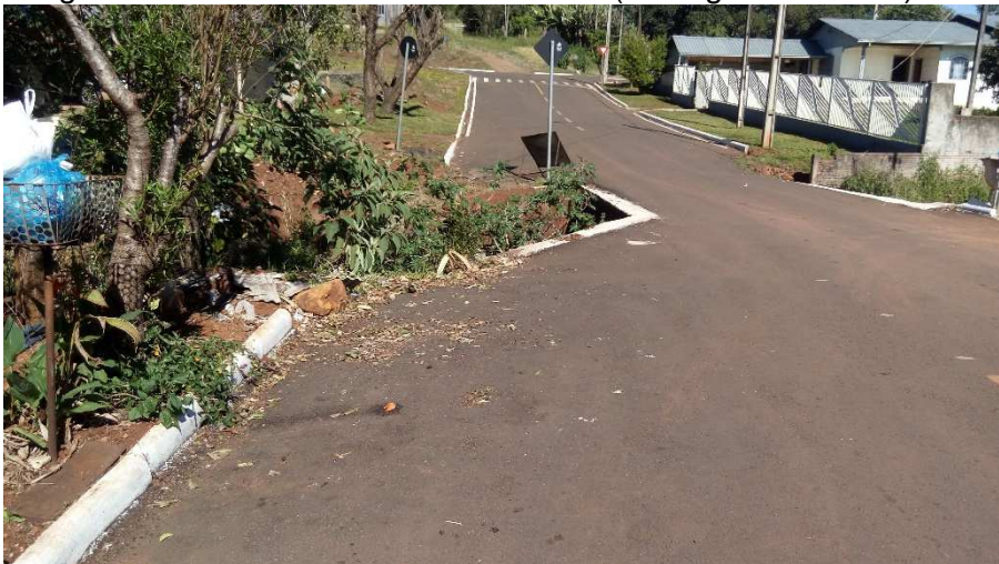
Fonte: Leonardi Engenharia (2020)
