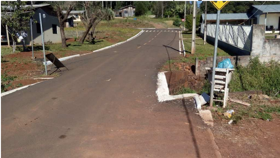
Fonte: Leonardi Engenharia (2020)
