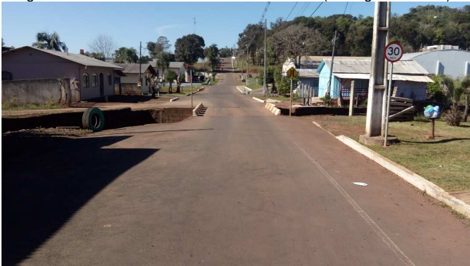
Imagem 01: Ponte na Avenida Alexandre Bonetti (Córrego São João)
