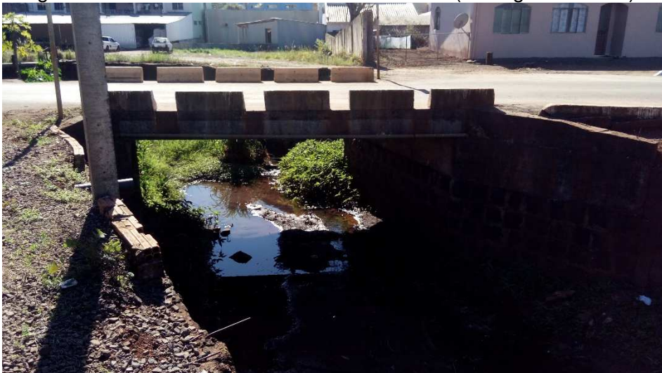
Fonte: Leonardi Engenharia (2020)
