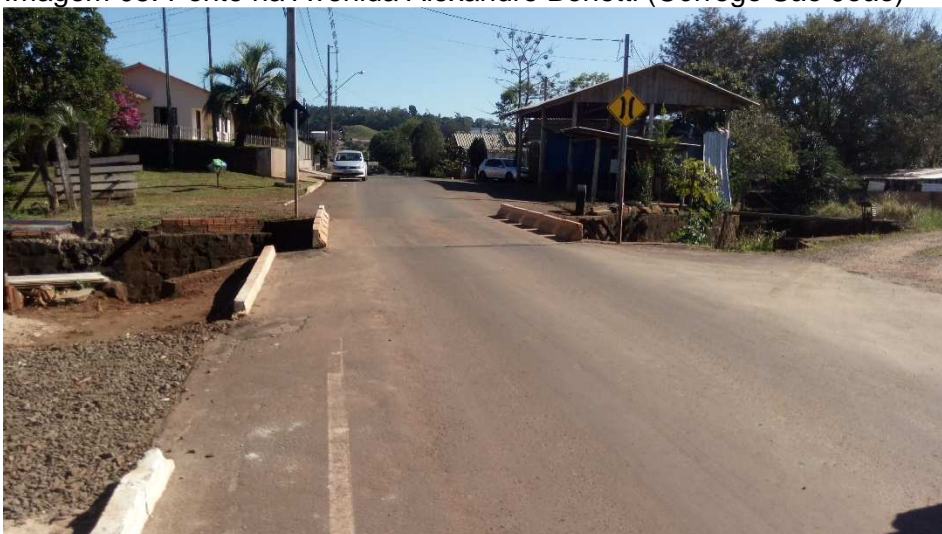
Fonte: Leonardi Engenharia (2020)
