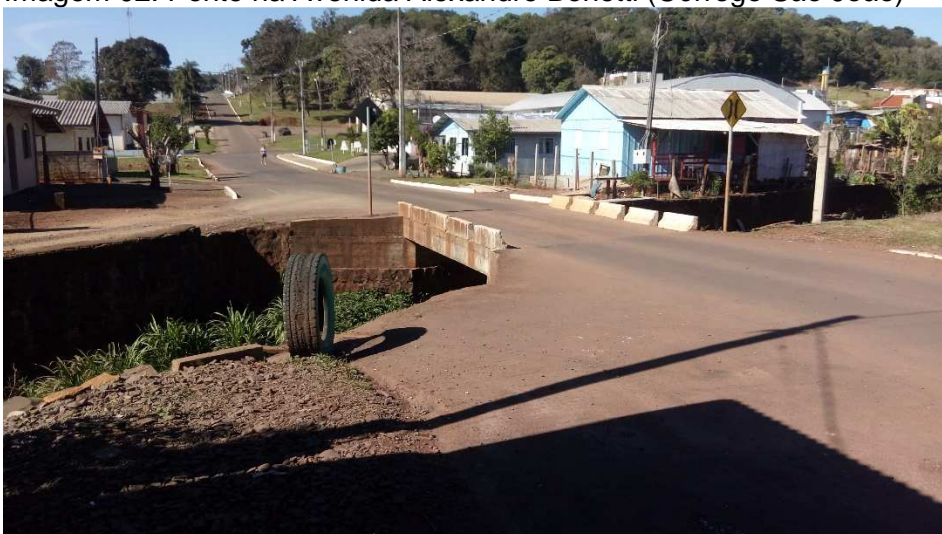
Imagem 02: Ponte na Avenida Alexandre Bonetti (Córrego São João)
