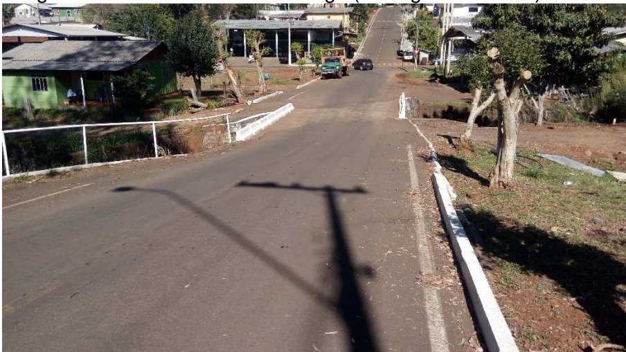
Imagem 10: Ponte na Rua Geni Fraga (Córrego São Pedro)
