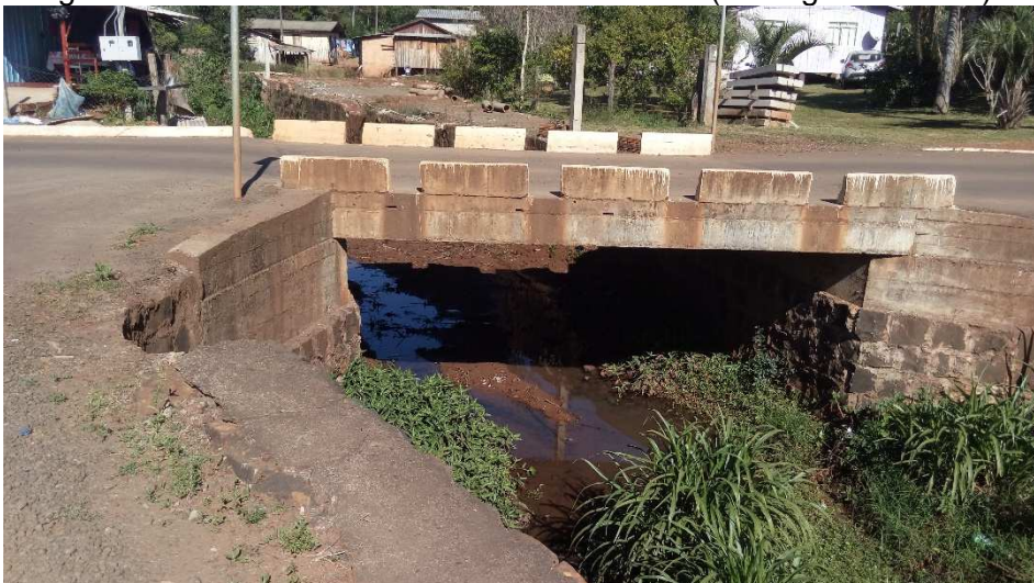
Fonte: Leonardi Engenharia (2020)
