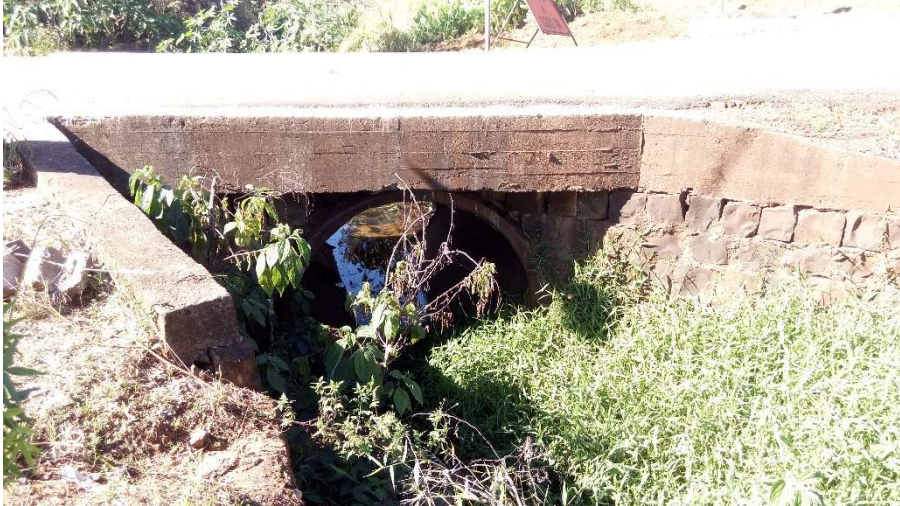
Fonte: Leonardi Engenharia (2020)
