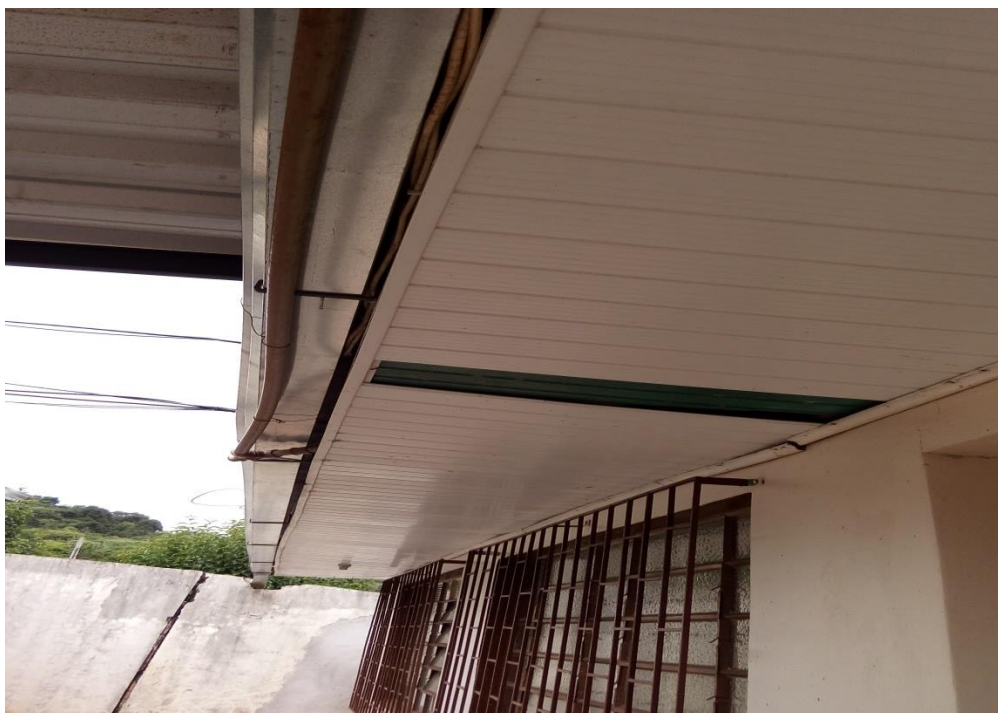
Figura 8 – beirais danificados;
