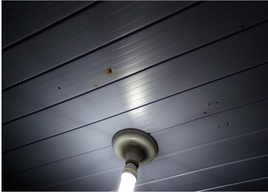
Figura 14 – substituição de forros;
