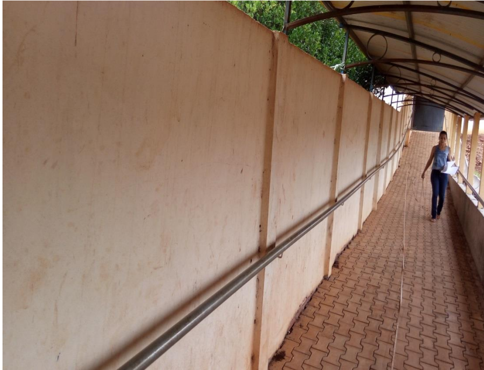
Figura 16 – pintura de muros, calçadas e estruturas de cobertura;
