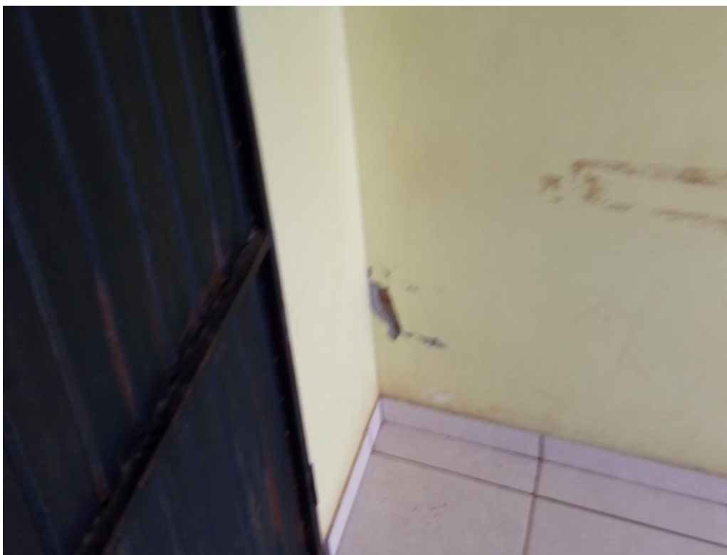
Figura 04 – parede de sala de aula;
