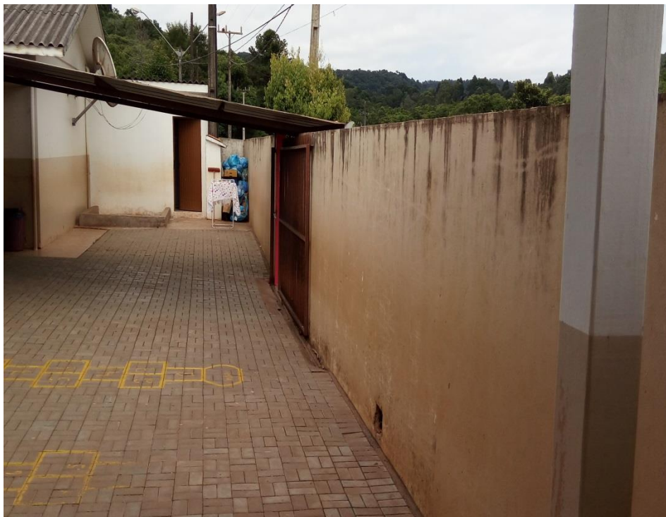
Figura 17 – pintura de muros, calçadas;
