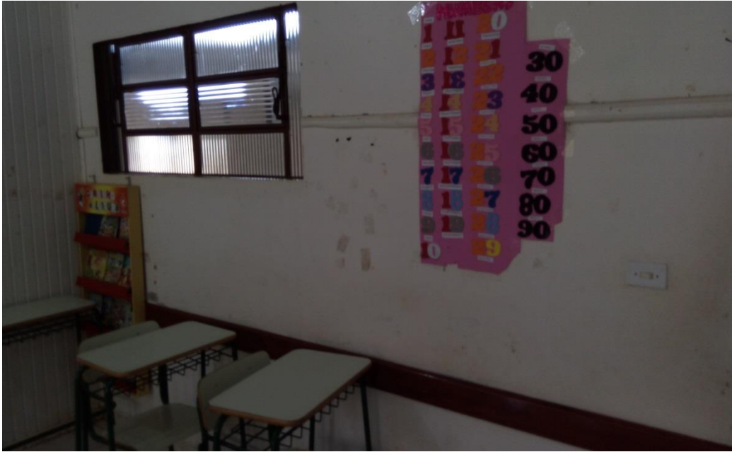
Figura 02 – paredes sala de aula;
