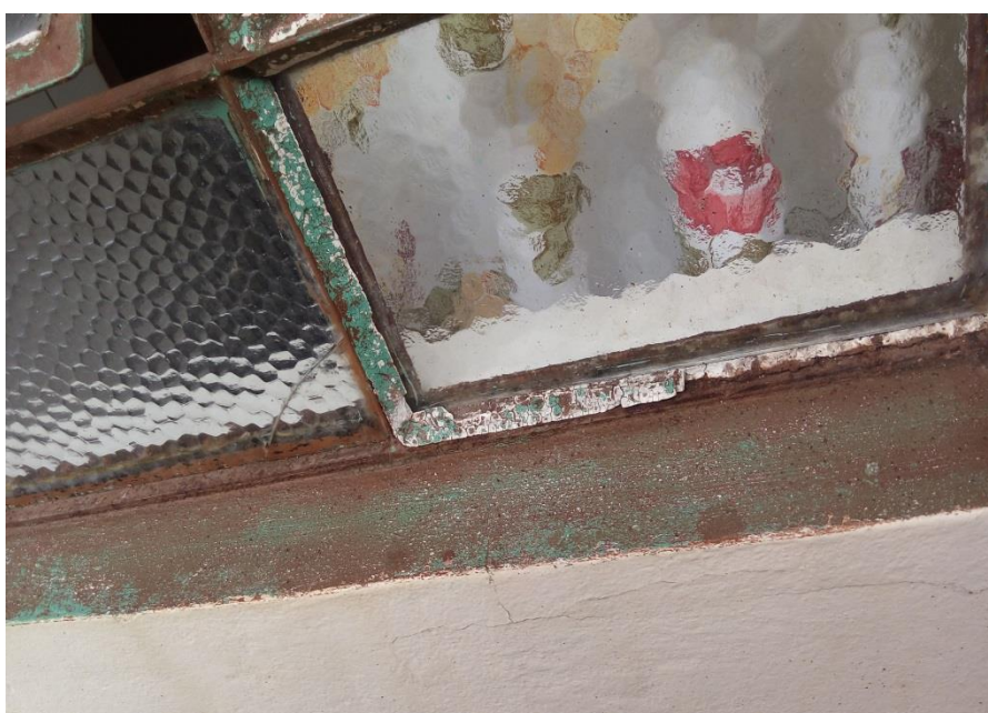
Figura 18 – pintura das janelas e portas de ferro e reinstalação de vidros;
