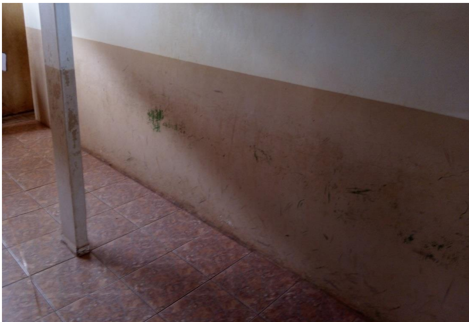
Figura 03 – paredes da área de circulação;
