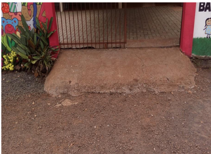
Figura 13 – melhoramento no acesso principal;
