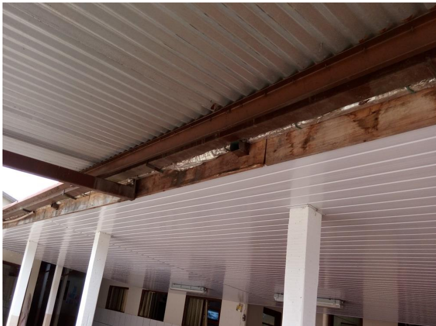
Figura 15 – instalação de calhas e platibanda na fachada da escola;
