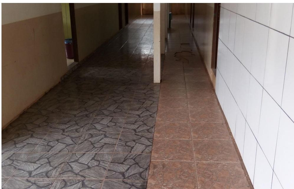
Figura 05 – pisos da área de circulação;
